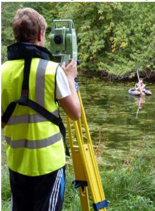
Figura 66: batimetria feita com estação total Fonte: http://www.wansteadpark.org.uk/news/lakes-bathymetric-survey-under-way/
