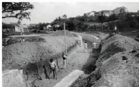
Locação canal avenida Hercílio Luz
