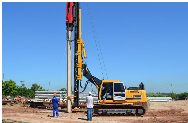
Estaca sendo cravada
