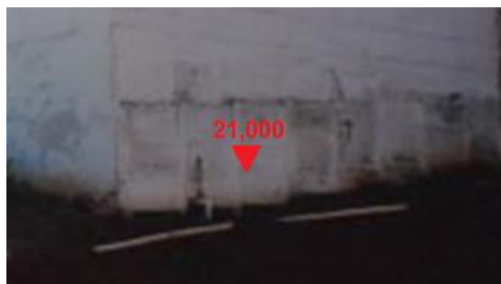
Figura 11: Cota 21,000 demarcada no muro
