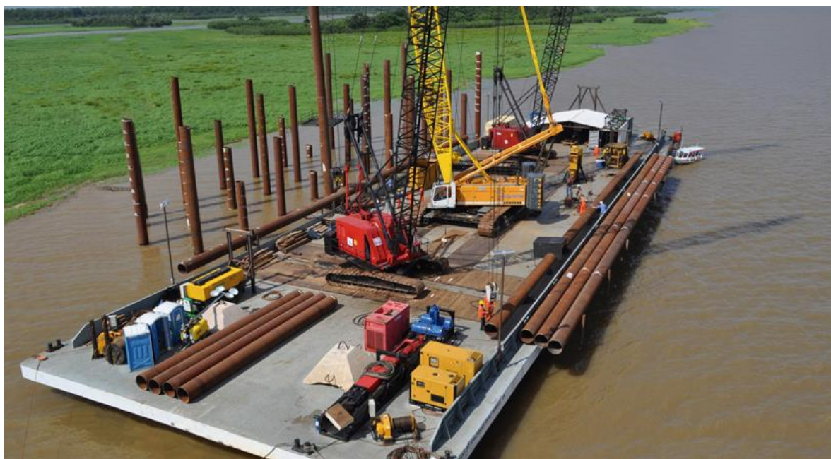
Flutuante para cravação das camisas Fonte: www.costafortuna.com.br
