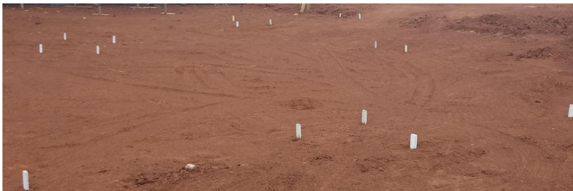
Piquetes indicando a posição das estacas
