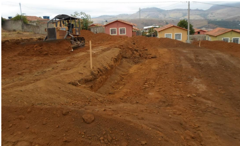
Estacas delimitando os platôs da terraplenagem Fonte: http://www.sinepomuceno.mg.gov.br/
