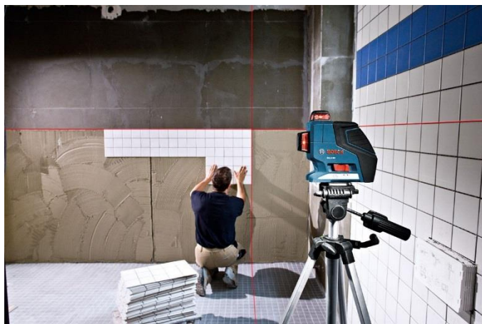
Figura 19: Nível laser demarcando os planos nas paredes Fonte: www.taringa.net
