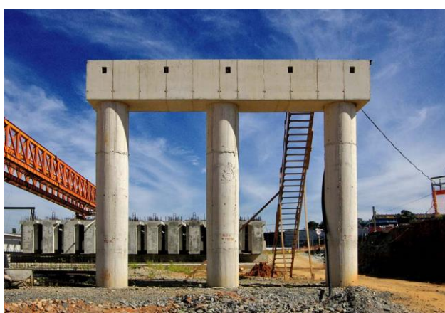
Mesoestrutura pronta de um viaduto Fonte: Mills do Brasil
