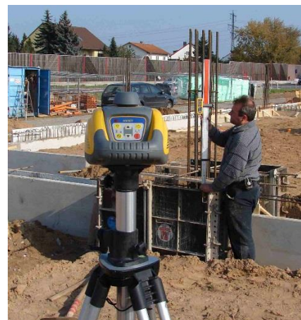
Figura 20: Nível Laser com sensor para identificar o plano Fonte: http://www.spectralasers.com/
