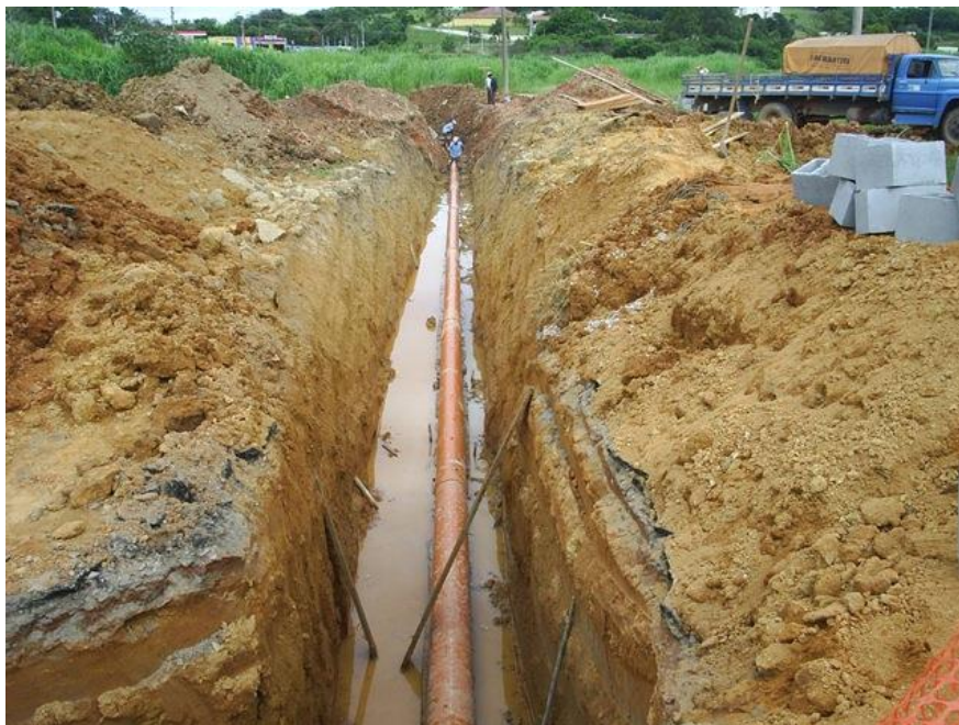
Vala escavada e tubo assentado Fonte: http://www.engenhariax.com
