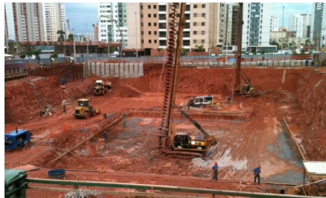
Estaca sendo escavada
