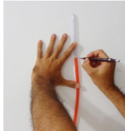
Figura 18: Marcação do nível no Ponto B Fonte: http://dicavirtualonline.blogspot.com.br/2014/02/como-fazer-nivelamento-de-piso-e-parede.html
