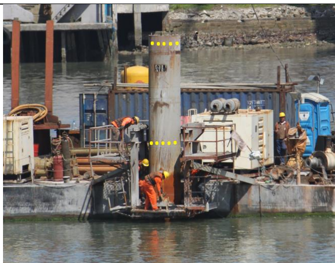
Pontos medidos na cota de arrasamento e no topo da estaca/camisa
