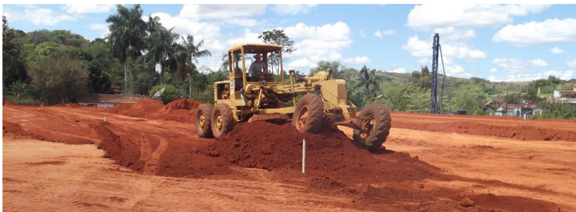
Estacas no meio de platôs extensos (a cada 20m) Fonte: http://tutiterraplenagem.com.br/
