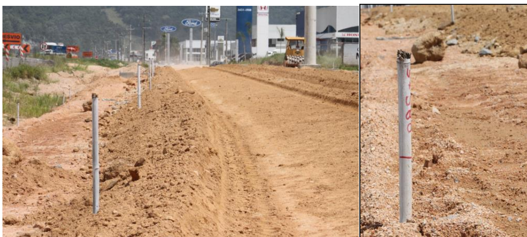
Estacas com anel identificando a altura exata do aterro
