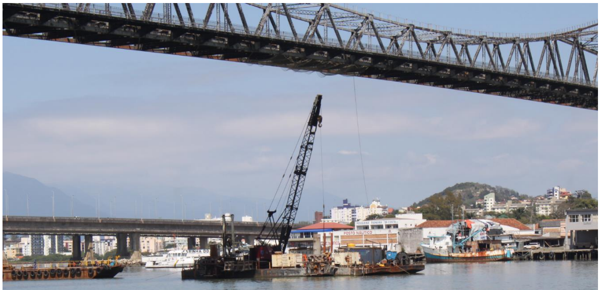
Guindaste sobre Flutuante posicionando a camisa para cravação
