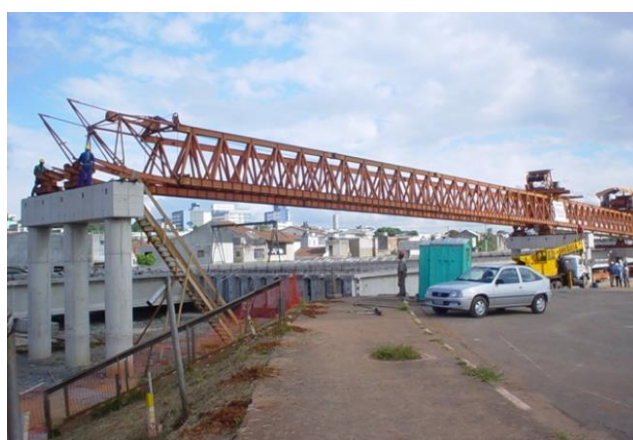
Superestrutura de um viaduto sendo executada Fonte: Mills do Brasil
