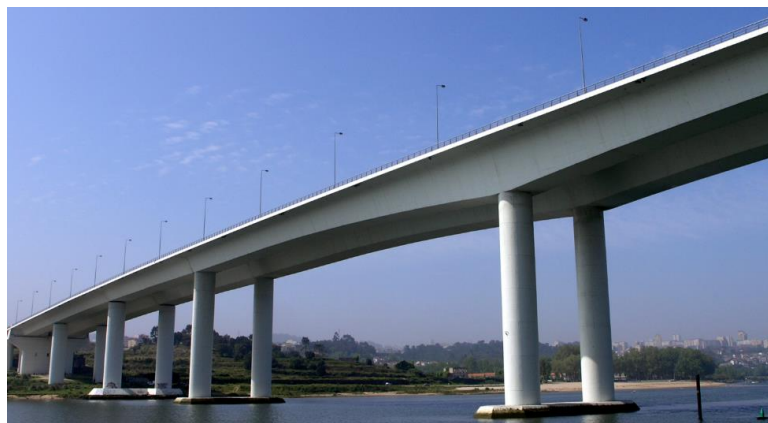
Ponte apoiada em sua mesoestrutura Fonte: www.datuopinion.com
