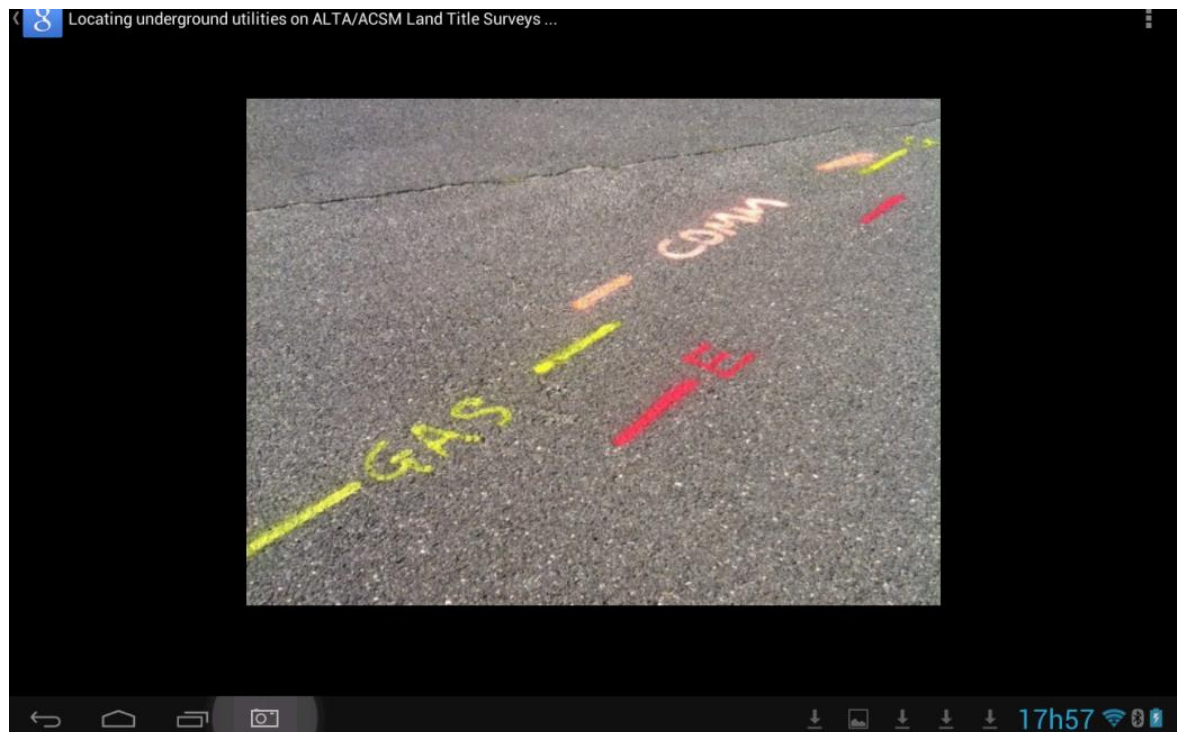
Figura 8: Locação da rede de infraestrutura com baseadas em detecção por radio frequencia; fonte: http://atlanticleak.com/utility-locating-faqs/
