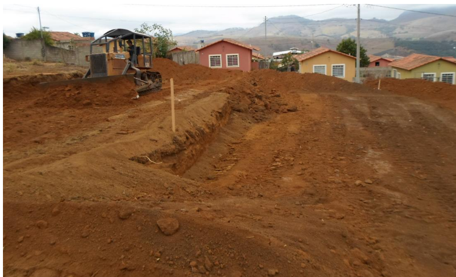
Estacas delimitando os platôs da terraplenagem
