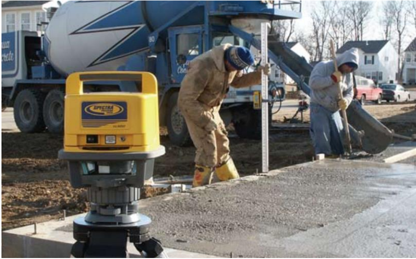
Nível Laser com sensor para identificar o plano
