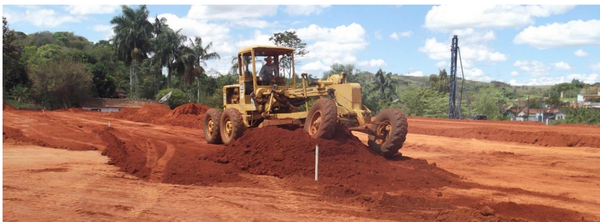
Estacas no meio de platôs extensos (a cada 20m)
