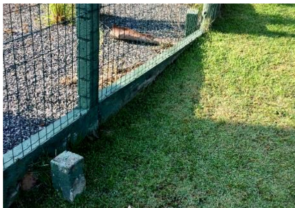
Figura 3: Exemplo de construção e marcos implantados.
