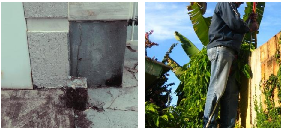
Figura 4: Exemplo de materialização com marco de concreto (esq.) e materialização com pino na parte superior do muro (dir.)
