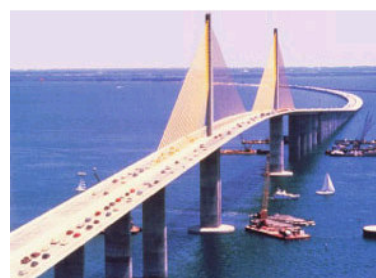
Fig. 8 - Sunshine Skyway Bridge. Fonte: Wikipedia
