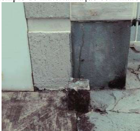
Figura 4: Exemplo de materialização com marco de concreto
