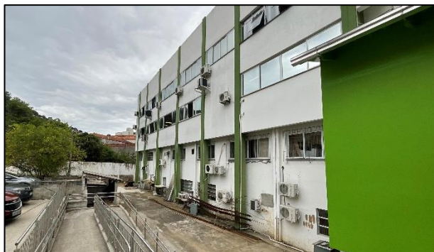
Figura 1 - Foto do local da fachada a ser levantada mostrando os obstáculos existentes no local. Fonte: Os autores.
